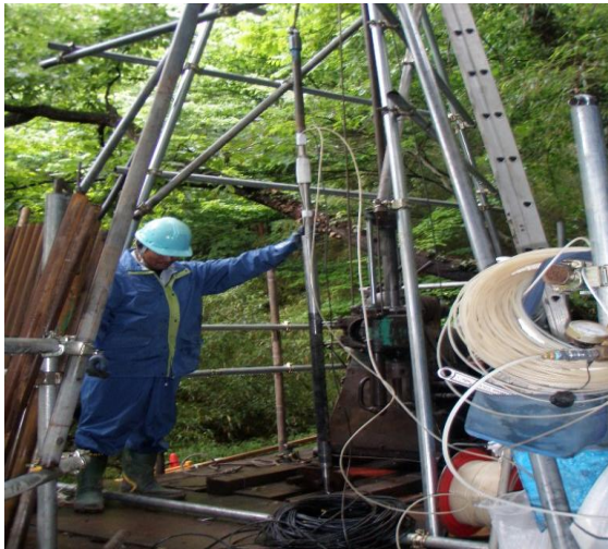
パッカー挿入状況
