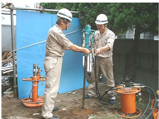
バイプロハンマーによる サンプラーの打ち込み状況
